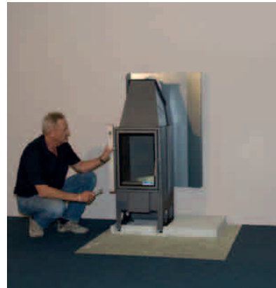
Orientar y nivelar la chimenea con la ayuda de un nivel
