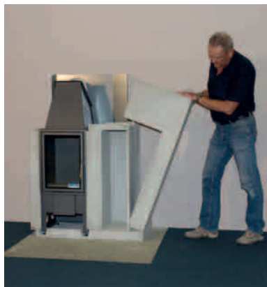
Ensamblar los elementos del revestimiento uno a uno y encolarlos
