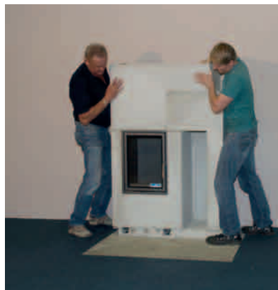
Ensamblar los elementos del revestimiento uno a uno y encolarlos
